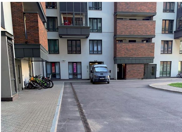
г. Санкт-Петербург, строительство ЖК «Дом на излучине Невы»
