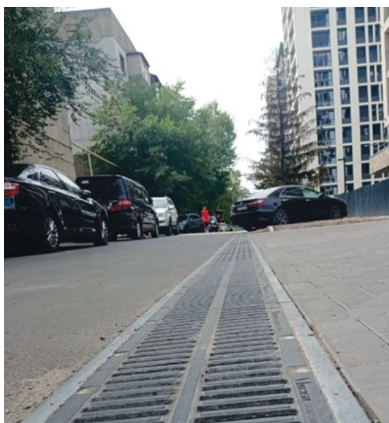
г. Алматы, ул. Штрауса
